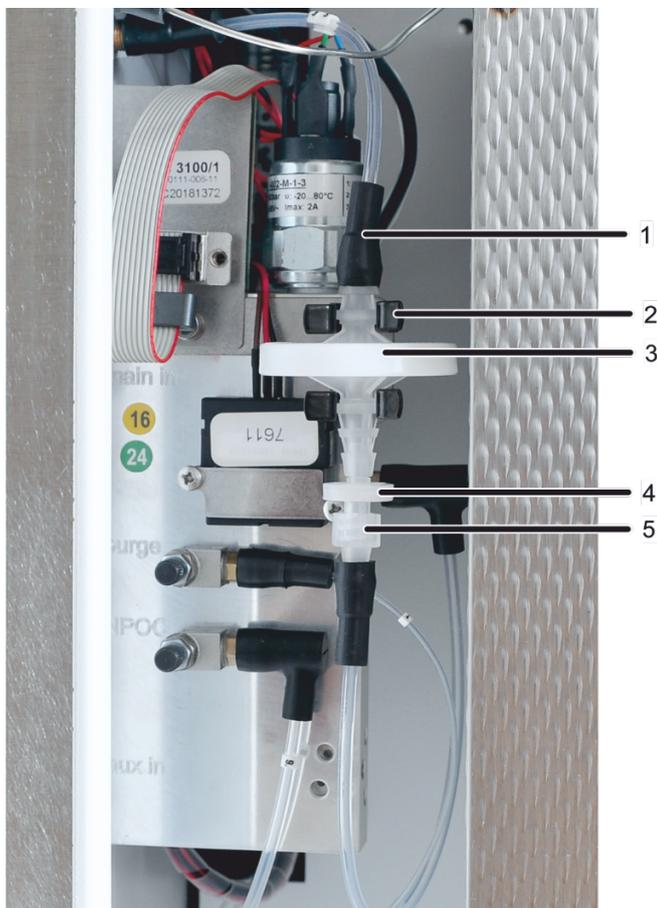
**Fig. 72** Sustituir las trampas de agua de la caja de gas
