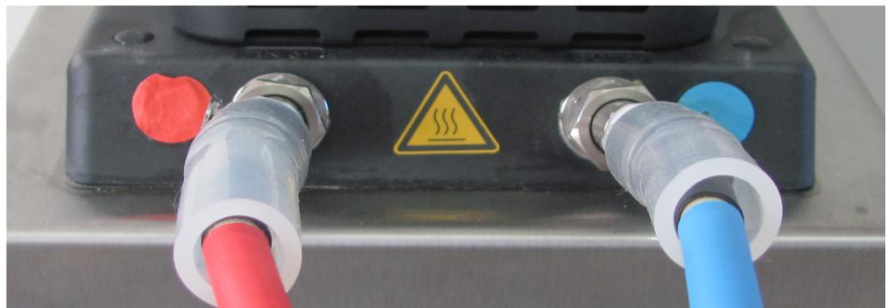
**Fig. 18 Termostato: conexiones en la parte trasera**
